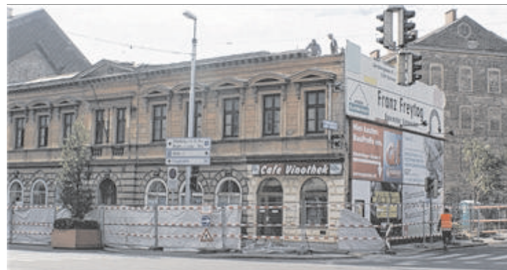
Foto vom Beginn der Abbrucharbeiten an der Wiener Straße 49. Foto: Herbert Zachs
